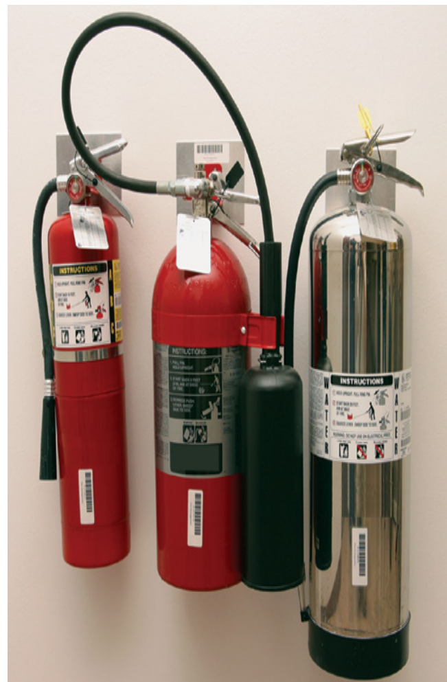
شکل ۱۲-۲ خاموش کننده ها باید در مکان هایی با دسترسی و دید بدون محدودیت نصب شود.
