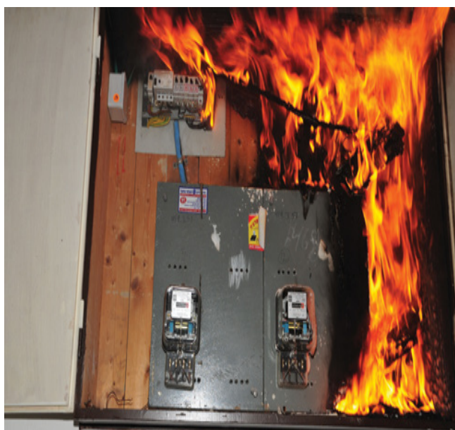
شکل ۷-۲ حریق های کلاس C شامل تجهیزات یا وسایل انرژی الکتریکی
